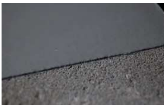
Protection Anti Acide sur béton
