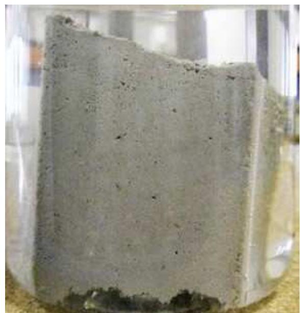
PAA27 après 6 mois dans l'acide chlorhydrique
