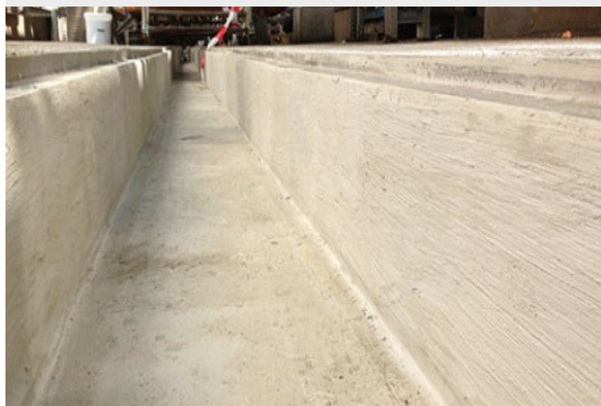
Rigoles de rétention produits chimiques
