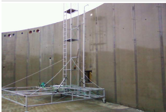
Silo sous H 2 S
